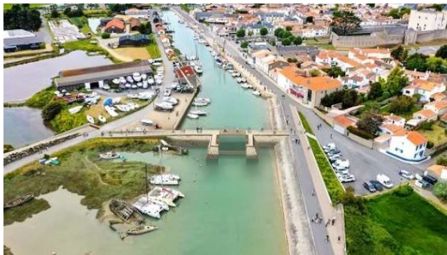
La principale porte anti-submersion sera installée dans l'étiér du Moulin qui arrive sur le port de Noirmoutier.
