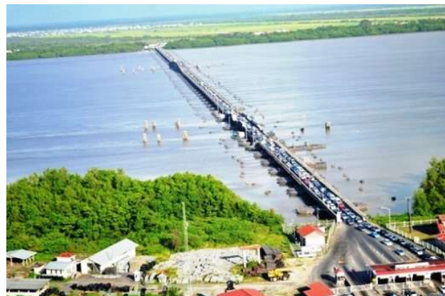
Vue générale du pont flottant Demerara couvert de véhicules.
