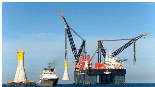
Nanti de grues de 10 000 t de capacité, le Sleipnir , l'un des plus grands navires installateurs au monde, a posé les fondations du parc de Fécamp à l'été 2022. (Photo : EDF EN)
