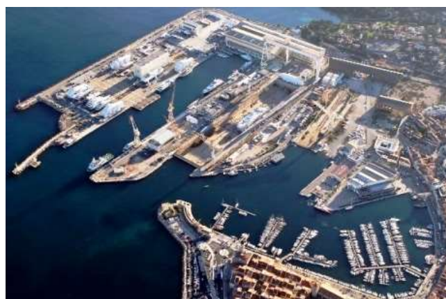
Vue d'ensemble du chantier "avant", en février 2020.
