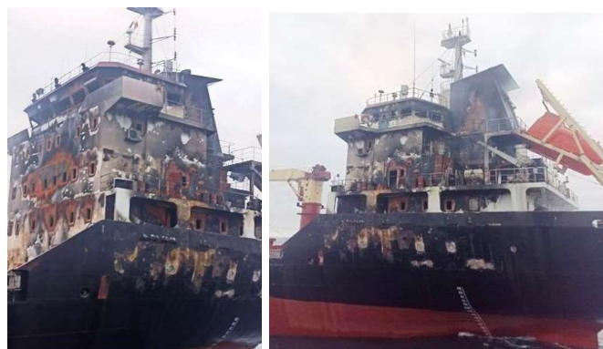
L'état de la coque et du château après l'extinction du feu. Le feu a balayé le pont et les emménagements. Curieusement, l'embarcation de sauvetage semble intacte. (Photos : Directorate General)
