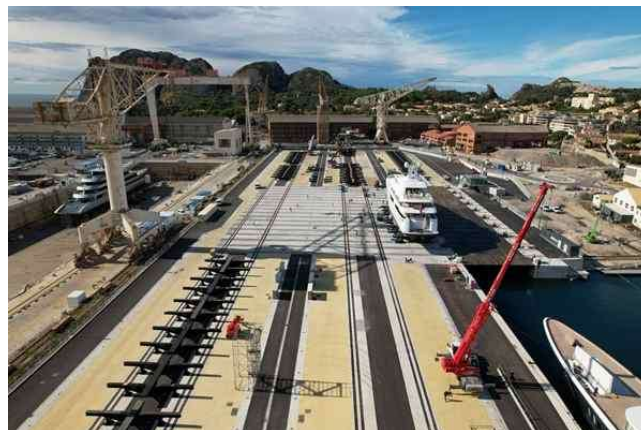
Le nouvel équipement avec l'ascenseur Atlas inauguré le 22 novembre.
