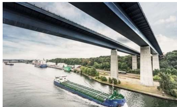
Les 2 ponts Holtenau concernés par cet accident. (Photo : Kiel-Canal.de)
