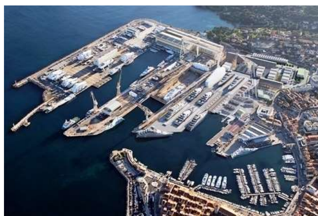
Vue d'ensemble du chantier "après", projection 2022.
