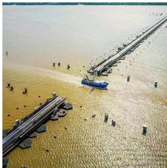
Le pont en situation normale avec le passage ouvert.
