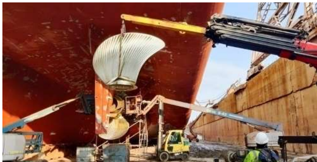
Mise en place des nouvelles pales d'hélice.
